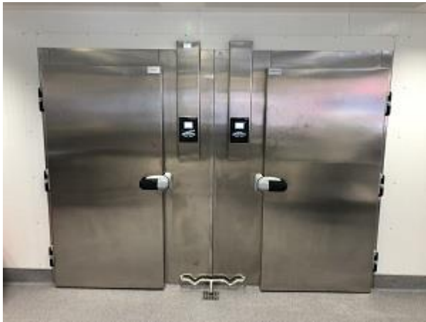
Küchenseite Modell MX 4 S TS - Tauwasserablauf zusammengeführt
