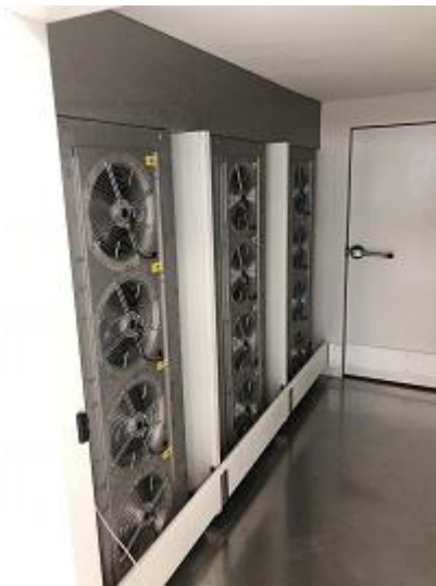
Innenraum mit EF-Verdampfersysteme
