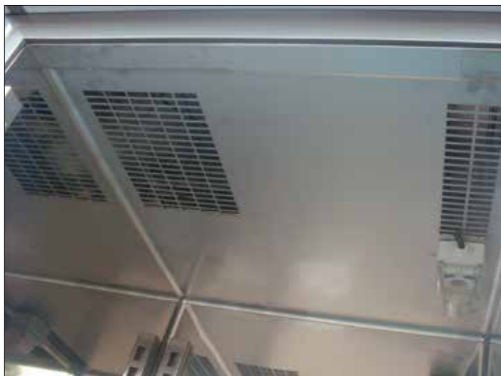
Deckenuntersicht mit Ein- und Ausblasöffnungen (TEC-Line)
